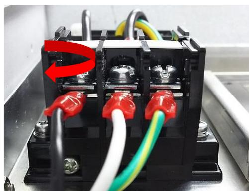
※ 端子台のうち、「E」にはアースケーブルを接続し、「L」および「N」には電源ケーブルをそれぞれ接続し、端子台から抜けないようにしっかりと固定してください。
